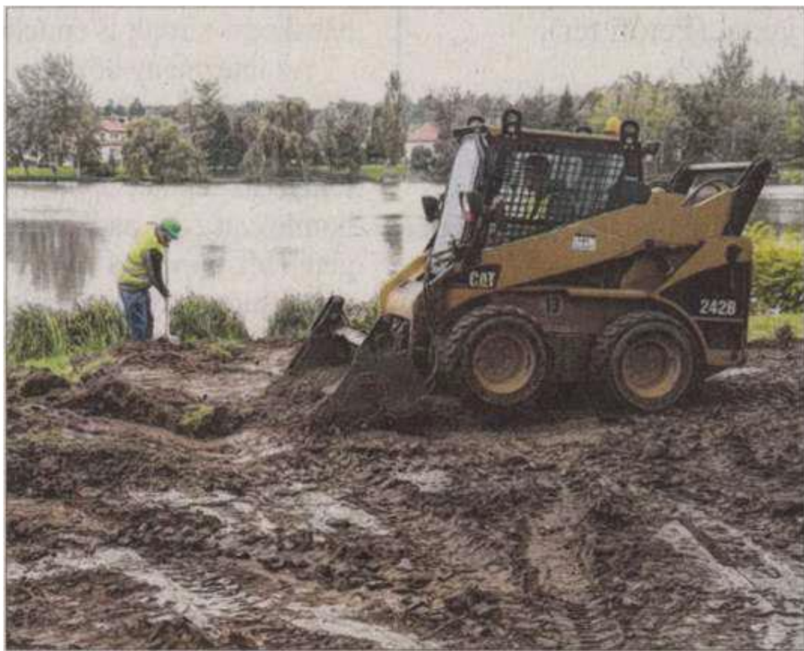
21. kép: A sétányon gépekkel ássák ki földkábelek helyét.
